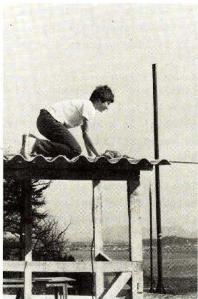
sl. 1. Učenec 8. razreda montira streho na bodočo hišico za shranjevanje teleskopov. V ozadju gnomon in pasažni inštrument. V ozadju sta Homec in tenceš.
