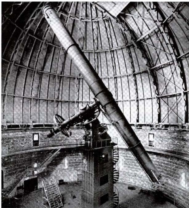
Slika 3. Clarky so izdelovali objektivne za največje refraktorje, ki so jih tudi montirali. Največji med njimi so na observatorijih: Lowell (premer objektiv 60 cm), Washington (66 cm), Pulkovo (76 cm), Lick (91 cm) in Yerkes (102 cm; na sliki). Yerksov objektiv je do danes ostal največji na svetu.
