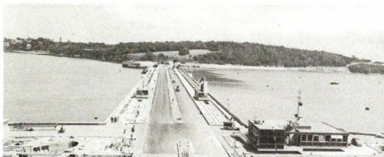
Sl. 6. Prva plimska elektrarna na svetu. Elektrarna leži na reki Rance blizu Saint-Maloja v Franciji kakih deset kilometrov od izliva v Rokavski preliv. Graditi so jo začeli leta 1961. Do 13 metrov visoko plimo pa so izkoriščali z mlini že pred petsto leti. Štiriindvajset turbin elektrarne delajo z največjo močjo 62,5 megawattov. Elektrarna dela ob plimi, ko se polni prostor nad jezom, in ob oseki, ko se ta prostor prazni.
