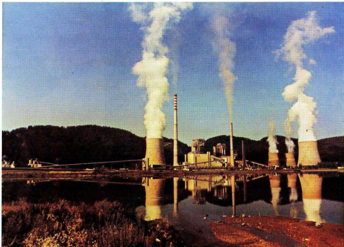
Slika 1 Pogled na Termoelektrarno Šoštanj. Z leve proti desni hladilni stolp četrte enote in njen dimnik, zgradbe četrte in tretje enote in prvih dveh enot, dimnika tretje enote in prvih dveh enot ter hladilni stolpi druge, prve in tretje enote.
